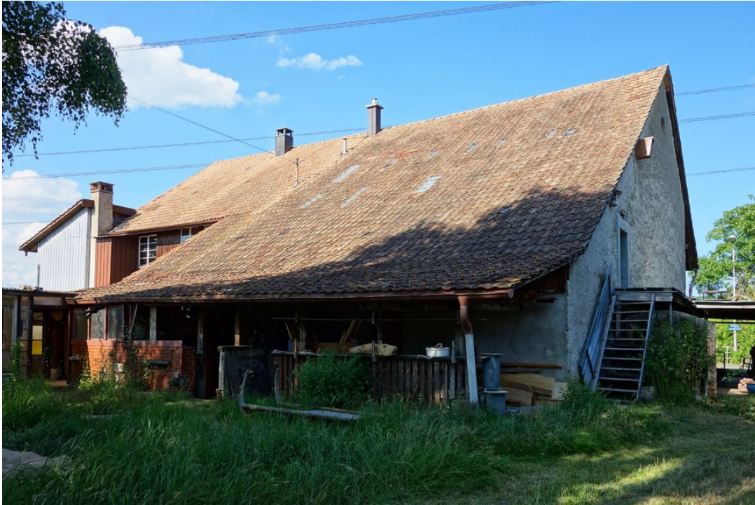
Abb. 09 Westseite des Hauses
