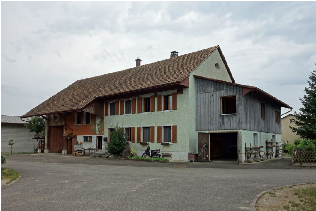
Abb. 08 Aussenansicht von Osten
