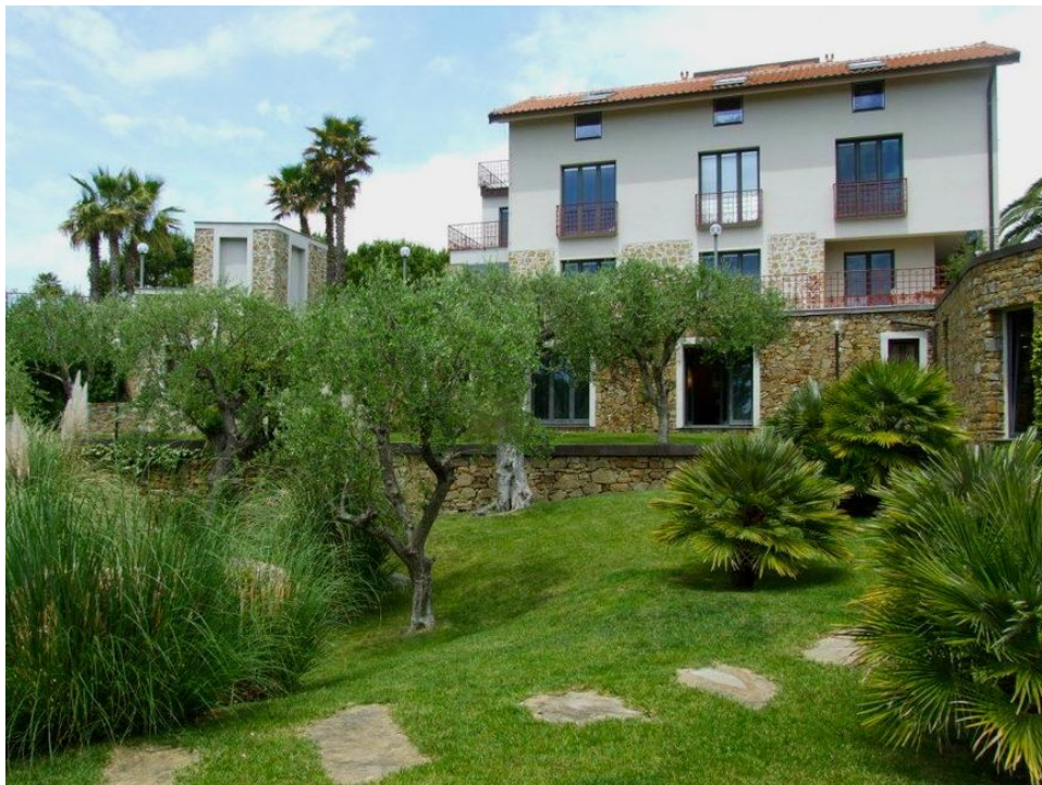
Abb. 24 : Ansicht der Südfassade
